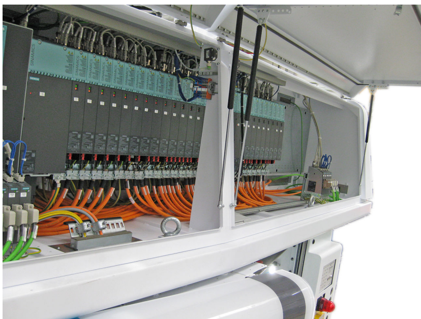
Beispiel: Schaltschranktüren an einer Mehrspindel- Drehmaschine
